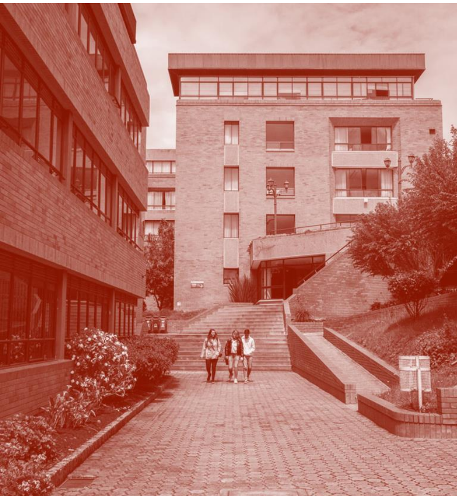
Fotografía del Edificio 3 y del Edificio central – Sede Tunja
